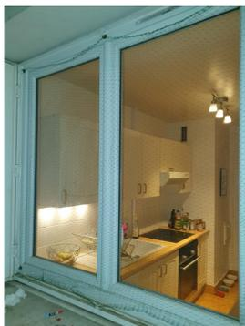
Pour mettre en place le filet sans percer le bâti, nous conseillons les **attaches Bird -Tech**. Sur les parties auxquelles le chat pourrait avoir accès, nous recommandons de les coller tous les 5 à 10 cms les unes des autres (et non 25 cms comme indiqué sur l'emballage). Si les attaches sont trop espacées, un chat aventureux pourrait arriver à passer en les faisant sauter.
